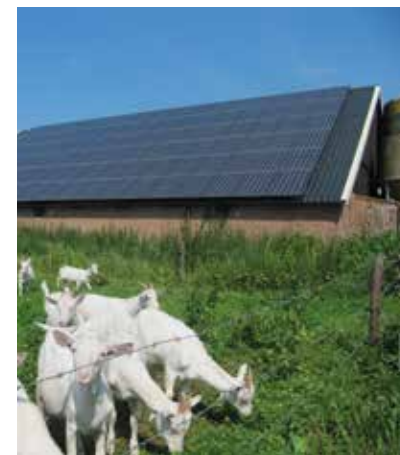
Zonnepanelen op een stal in Twickel.
