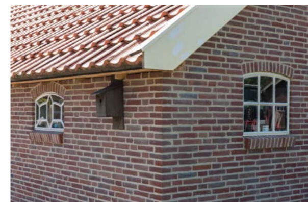
Aan de achterkant (rechterraam) van de bakspieker mogen nieuwe vormen gebruikt worden. De vormen aan de voor- en zijkant blijven traditioneel.
