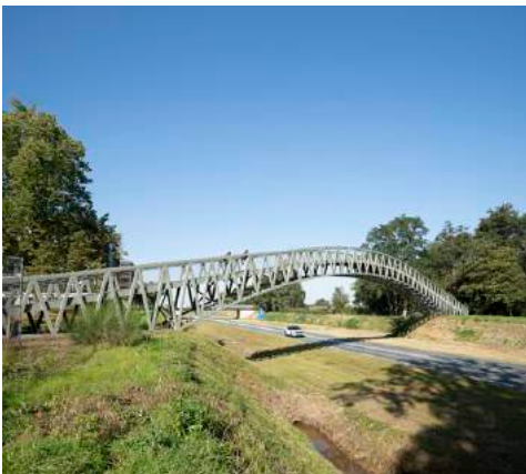
Nieuwe voetgangersbrug bij de Marktstraat
