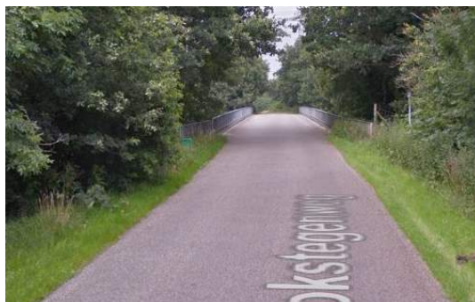
Groene overgang over de A1 bij Borne-West
