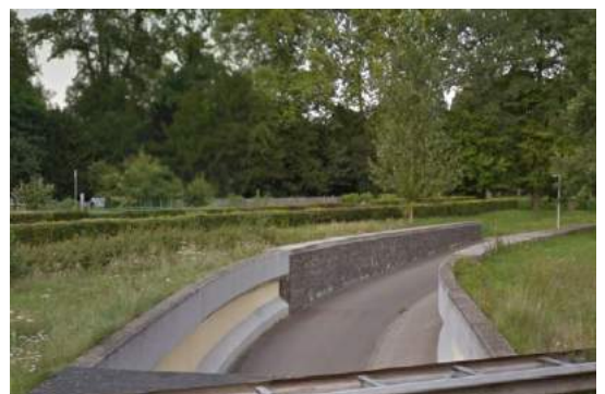
Tunnel Rentmeesterlaantje: goed onderhouden
