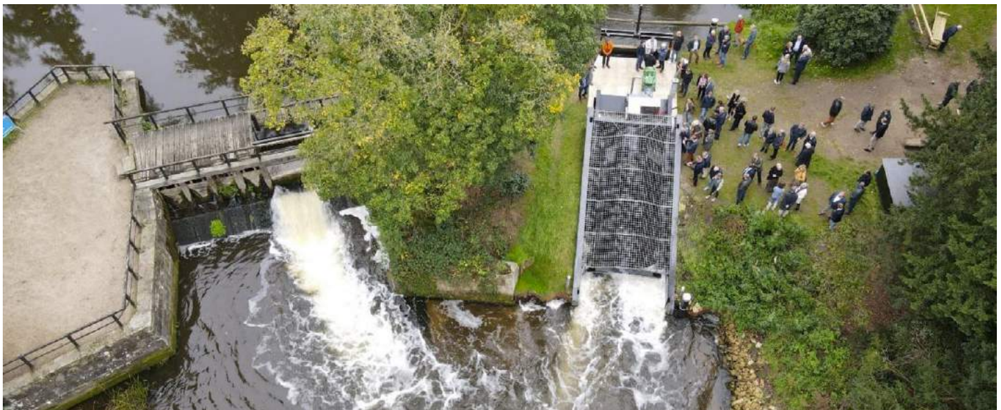
Met de vijzelturbine wordt in landgoed Singraven de waterkracht gebruikt voor het opwekken van elektrische energie.
