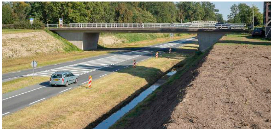
Taluds zijn steiler gemaakt
