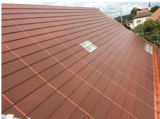
Geïntegreerde zonnepanelen op daken
